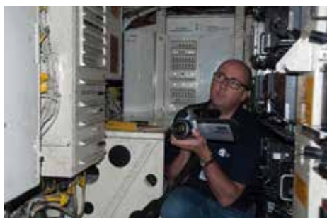
La FLIR P640 nous permet de voir les plus petits composants électriques et les plus petites différences de température.
